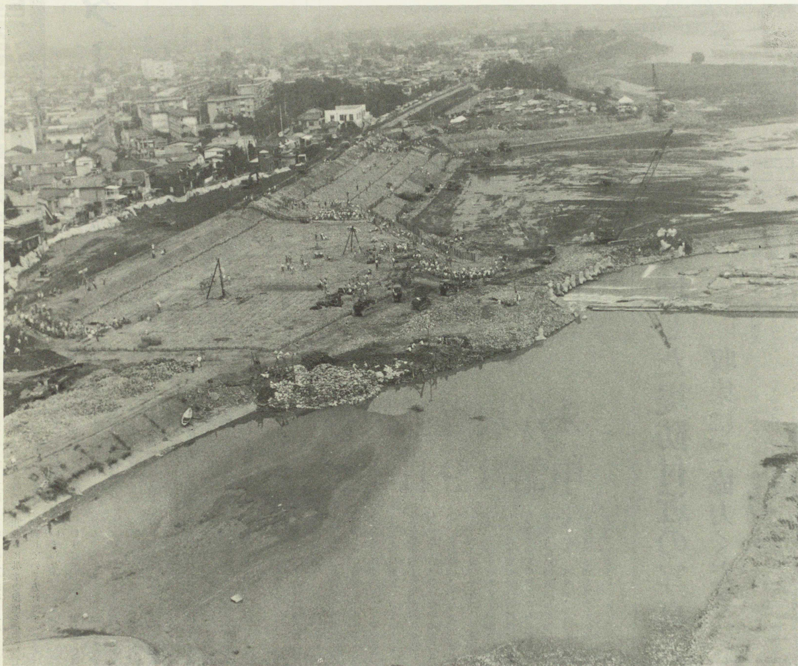
これで「安心」……完成した仮堤防——建設省提供
